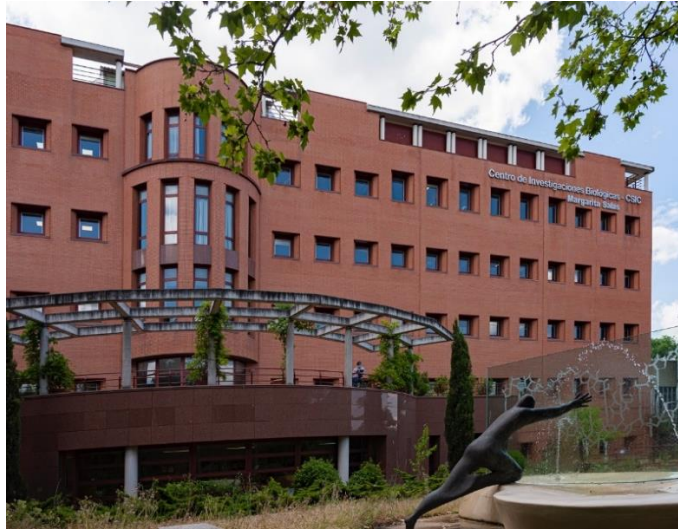
Edificio del CIB de la Calle Ramiro de Maeztu en la Ciudad Universitaria de Madrid
